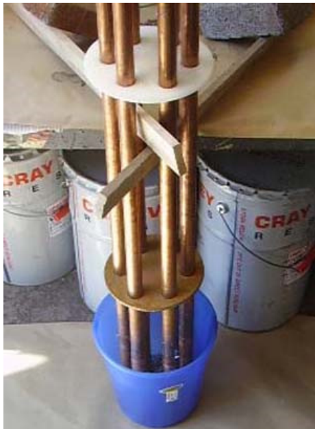
Finn en måte å støtt den opp på under støpning.
